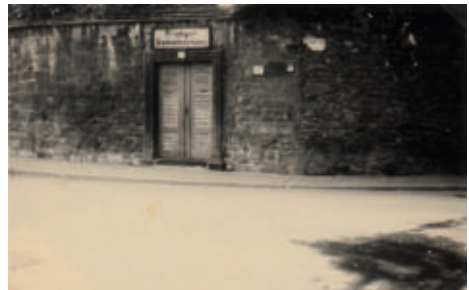
Die alte Eingangstür
